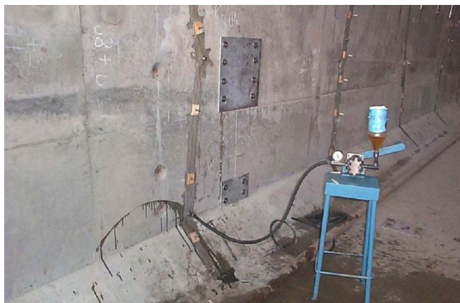
Рис. 33. Инъектирование трещин по высоконапорной технологии
