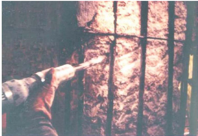
Рис. 13. Подготовка поверхности с помощью бучарды.
