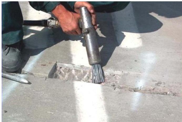
Рис. 14. Подготовка бетона игольчатым пистолетом
